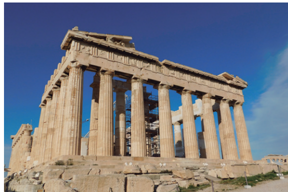
Fig. 10. El Partenón, construido entre el 447 y el 438 a. n. e., es un ejemplo de la arquitectura dórica, caracterizada por su simplicidad.
